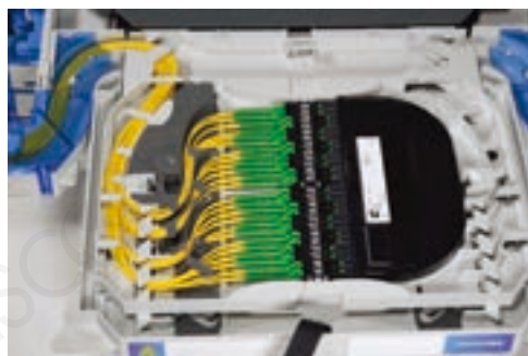
图 15: 显示的增值模块加载到 FACT NG4 配线箱中
